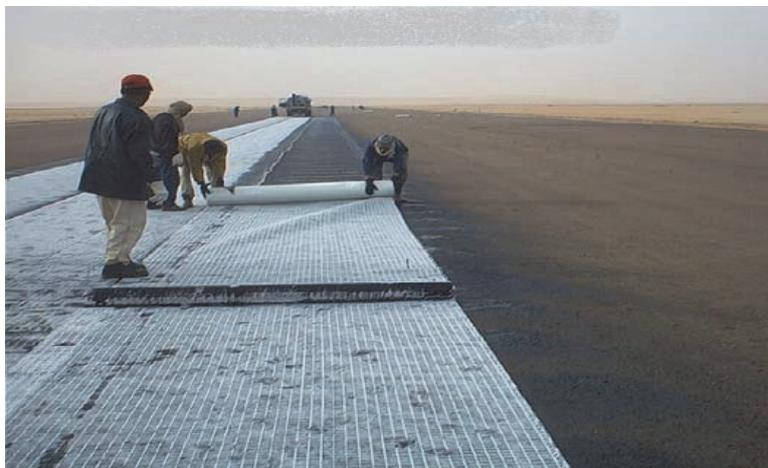
Figure 2. Mise en place de la géogrille
