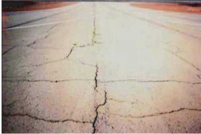
Figure 1. Fissures transversales au niveau de la chaussée.
